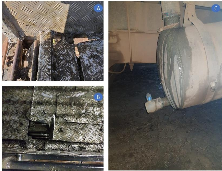
Figura 7 – Fotografias de buracos, rachaduras e pontas cortantes no piso (A e B) que podem ferir e causar lesões nos animais, assim como interferir na sua condução espontânea e de um tanque de coleta de resíduos com vazamento (C), sendo ineficaz na retenção do conteúdo.
