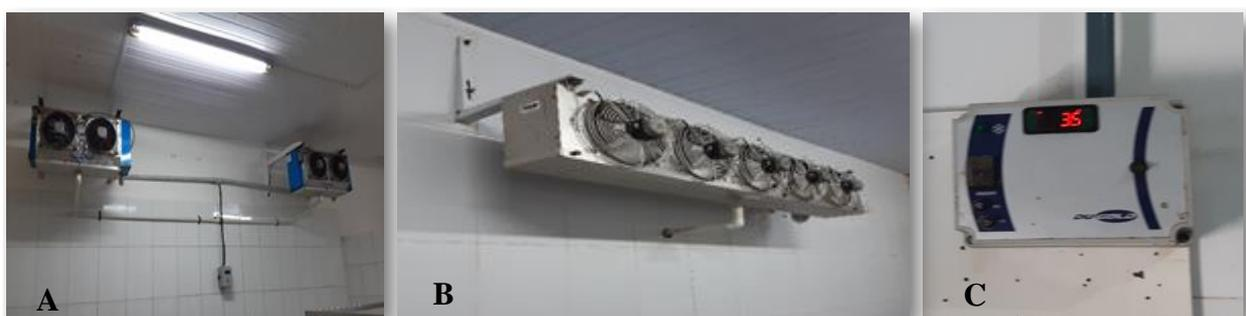
Figura 4 - Instalação elétrica (A), equipamento de refrigeração para manutenção da temperatura, variando de 10 a 16°C em todo ambiente de processamento (B) e controle de temperatura (C) em uma agroindústria de embutidos cárneos em Pelotas/RS, 2019/21.
